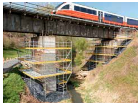
Stuletni most o długości 40 m przechodzi kompleksową renowację z wykorzystaniem podwieszonego rusztowania Ringlock.
