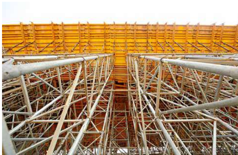
Firma ULMA uczestniczy w budowie najdłuższej estakady w Małopolsce, realizowanej na odcinku S7.
