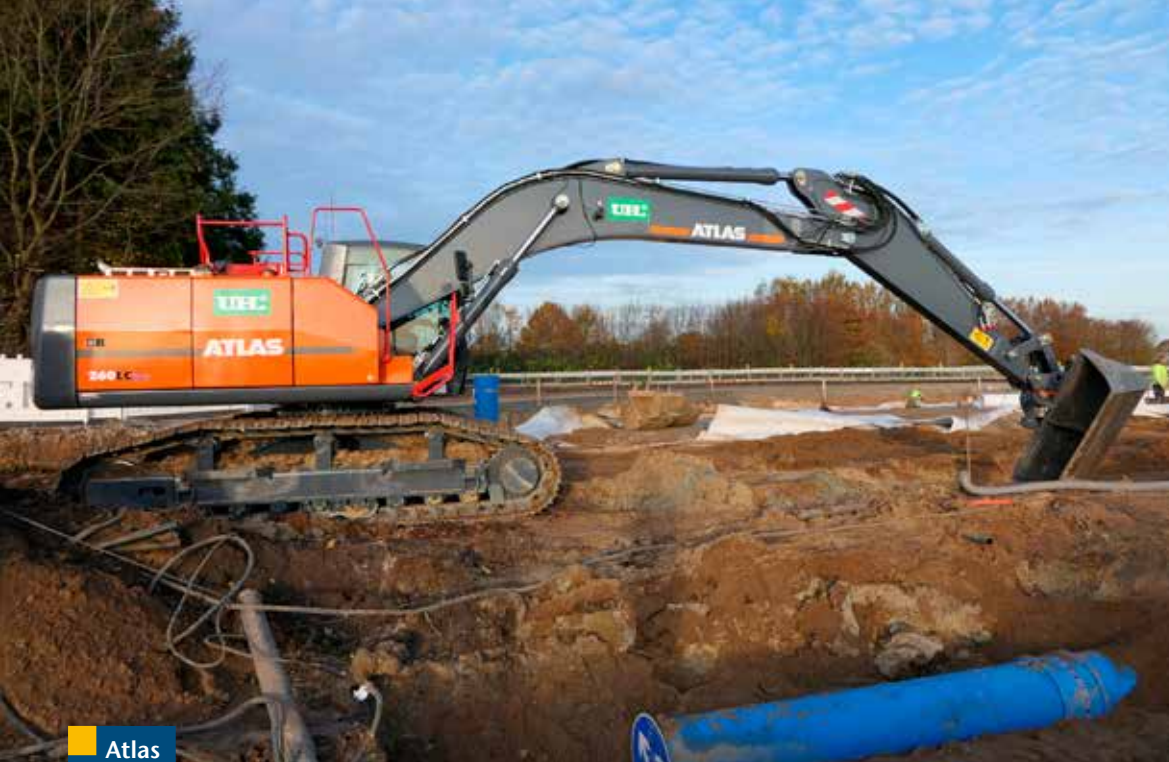
Atlas 260 LC podczas robót ziemnych przy budowie ronda w Rellingen.
