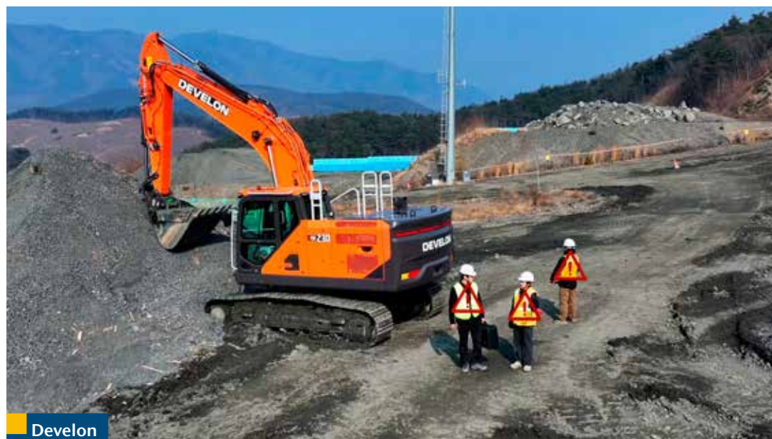
Koparka gąsienicowa Develon z serii 9 wyposażona w system E-Stop podczas pracy na placu budowy
