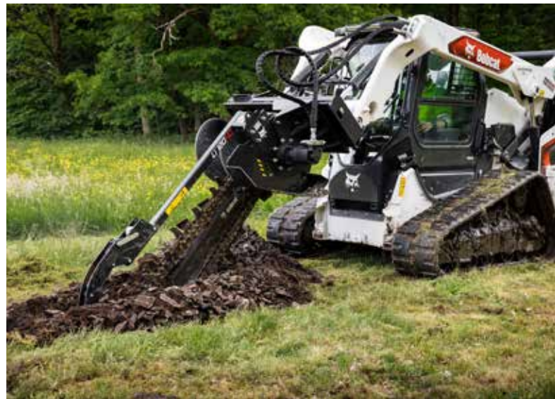
Koparka do rowów LT120 HD w trakcie wykonywania wykopu o głębokości 1,5 m.
