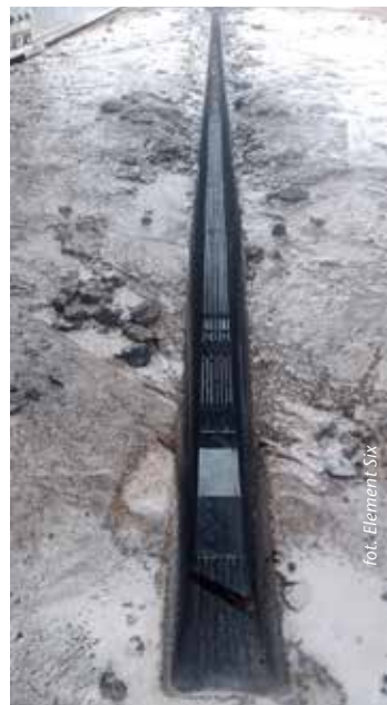
Zastosowanie diamentowych narzędzi tnących pozwala ograniczyć ilość generowanego urobku o ponad 17% w porównaniu z metodami tradycyjnymi.
