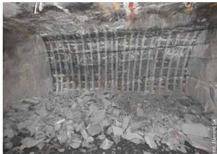
Zastosowanie diamentowych narzędzi tnących pozwala ograniczyć ilość generowanego urobku o ponad 17% w porównaniu z metodami tradycyjnymi.
