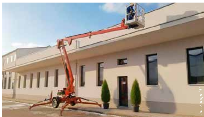
Maksymalny udźwignię kosza roboczego w modelu TM13GTi wynosi 220 kg, a jego obrót odbywa się w zakresie 2x45°.
